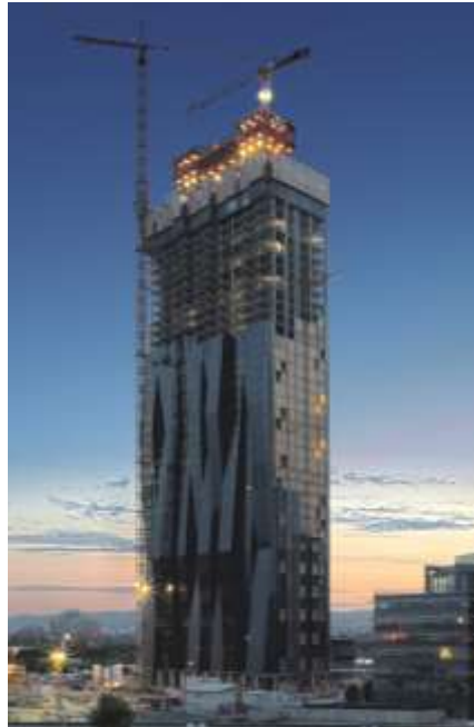
Abbildung 2: Kletterschalwerk an einem Hochhaus
